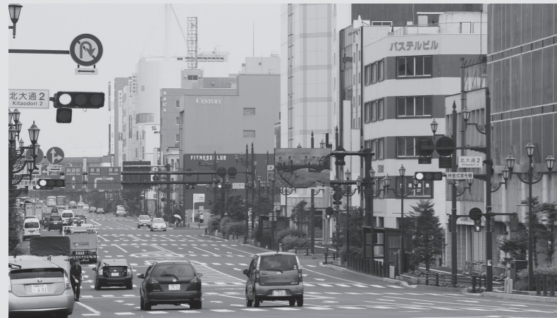
旧くしろデパートが立つ3丁目とバステルビルなどがある4丁目の2区画に複合ビルを建設
